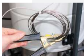
Liaison équipotentielle et mise à la terre
